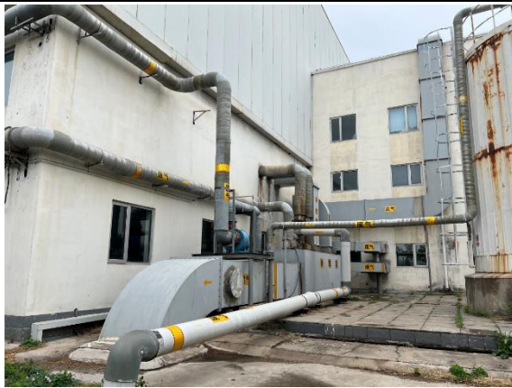
图 3.2.9 所有废气汇至主管道（利旧）
