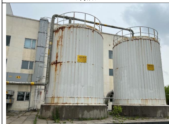
图 3.2.3 高位储仓顶部设排气口并连接集气管(利旧)
