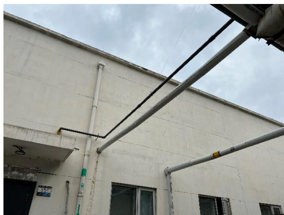
图 3.3.2 实验室废气管道（本项目建设）
