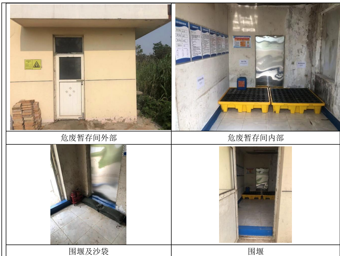
图 3.9 危险废物暂存间规范化设置情况
