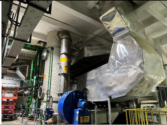
图3.2.7 喷淋式冷凝器顶部设排气口并连接集气管（利旧）
