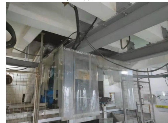
图 3.2.5 切碎机设置集气罩+软帘(利旧)
